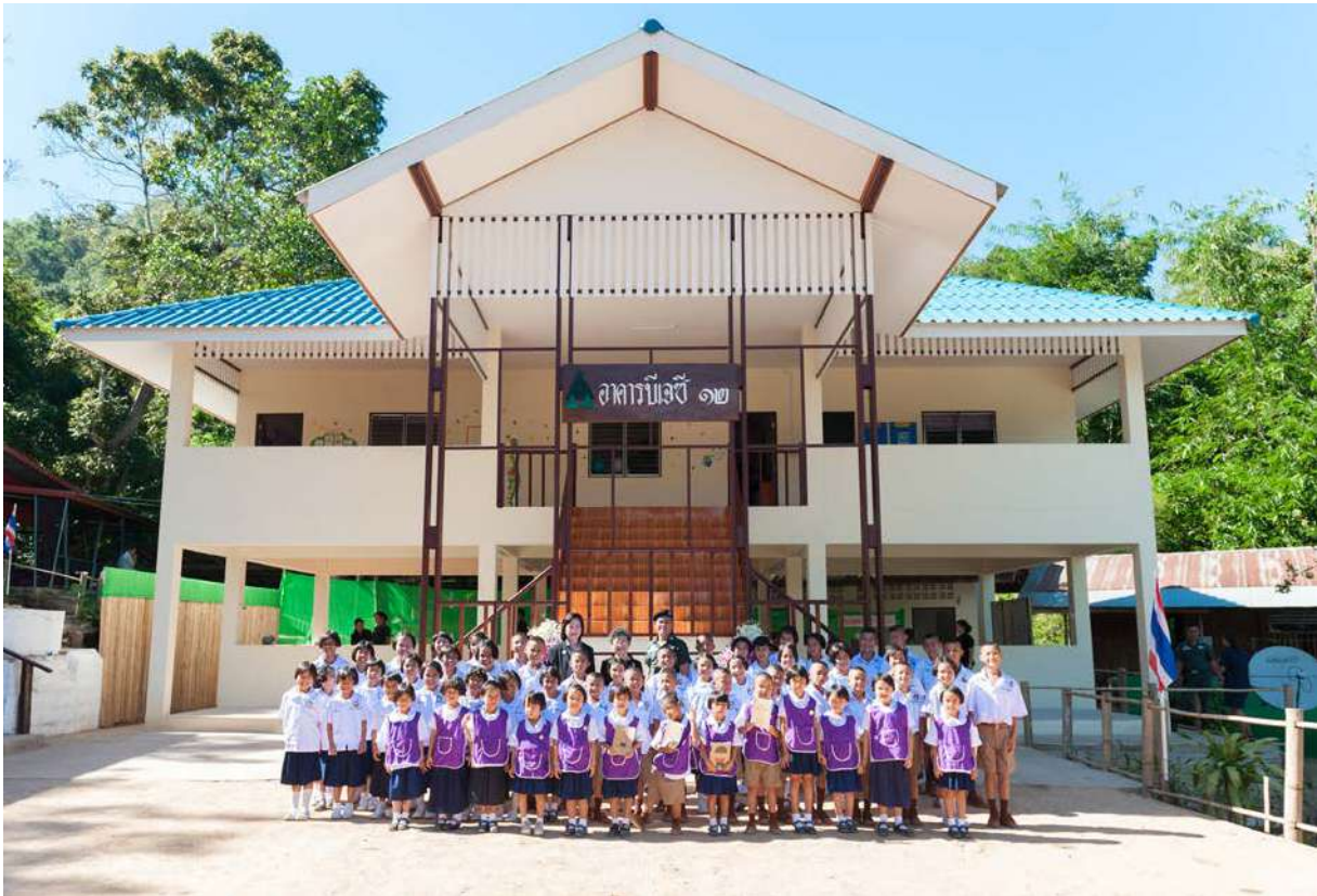
อาคารห้องสมุดในโครงการช่วยเหลือโรงเรียนขาดแคลน อาคารบีเจซี หลังที่ ๑๒ ณ โรงเรียนตำรวจตระเวนชายแดนบ้านกามาผาได้ อำเภอลำปาง จังหวัดตาก
